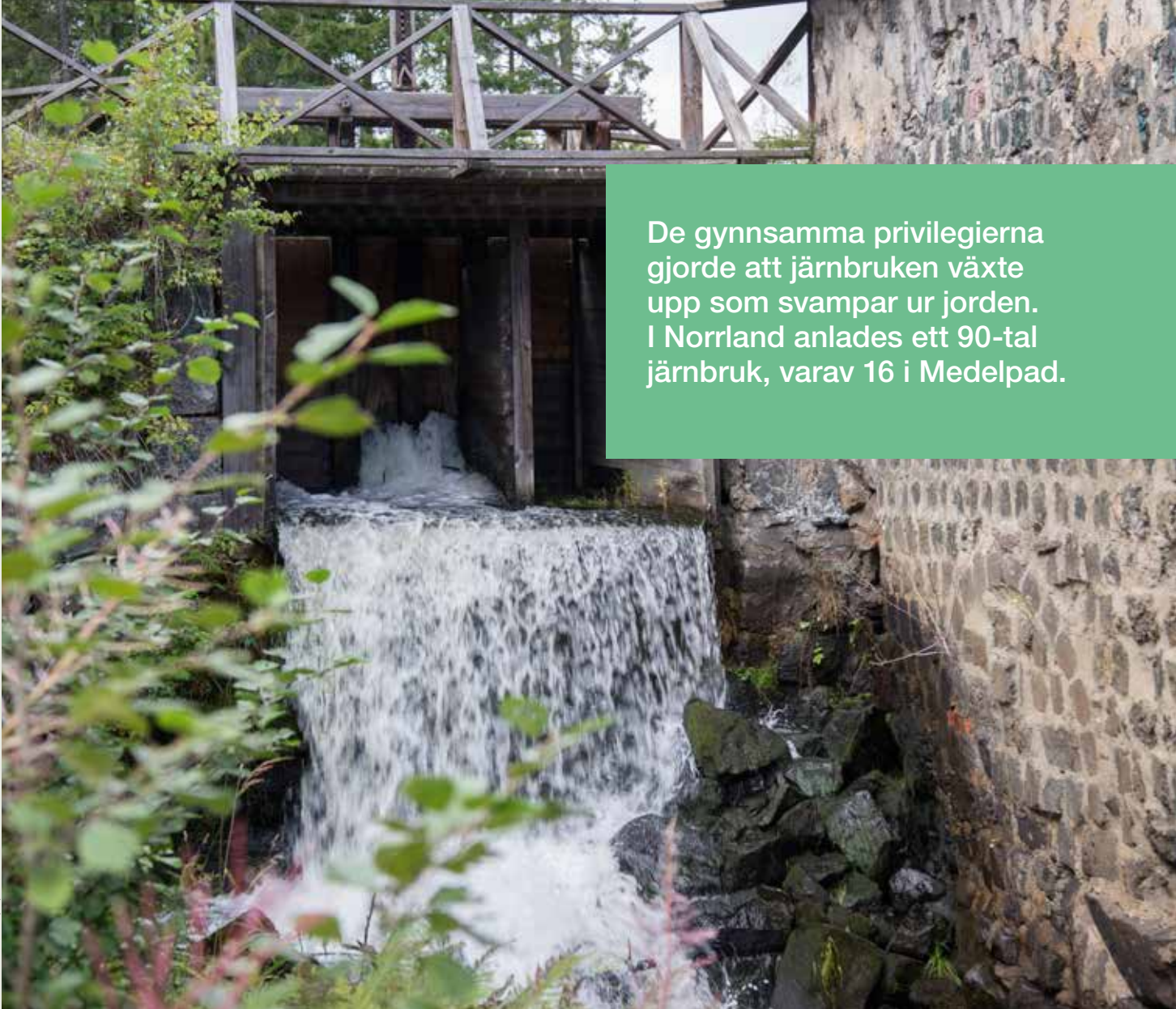
Utloppet från bruksdammen. Väggen till höger är byggd av slaggsten från bruket.
