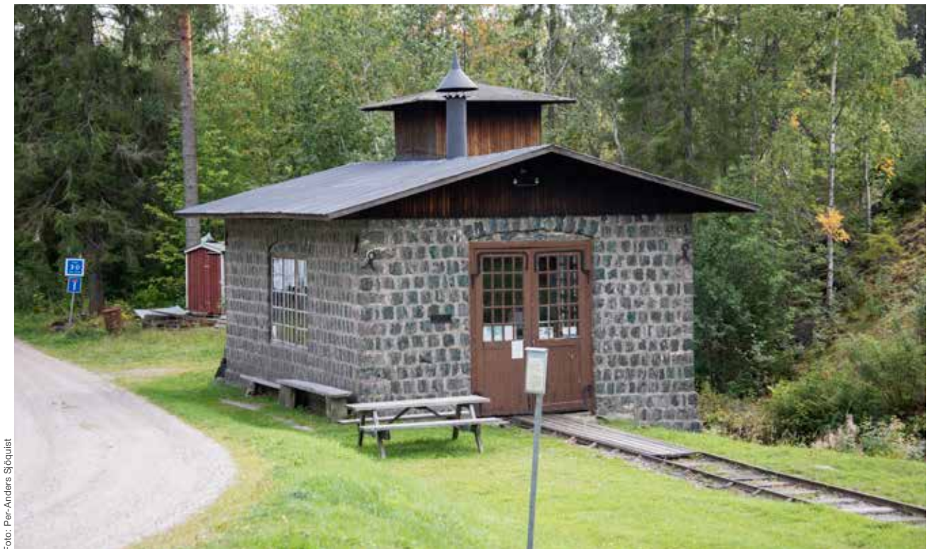
Lokstallet är en av byggnaderna som är helt byggd av slaggsten.
