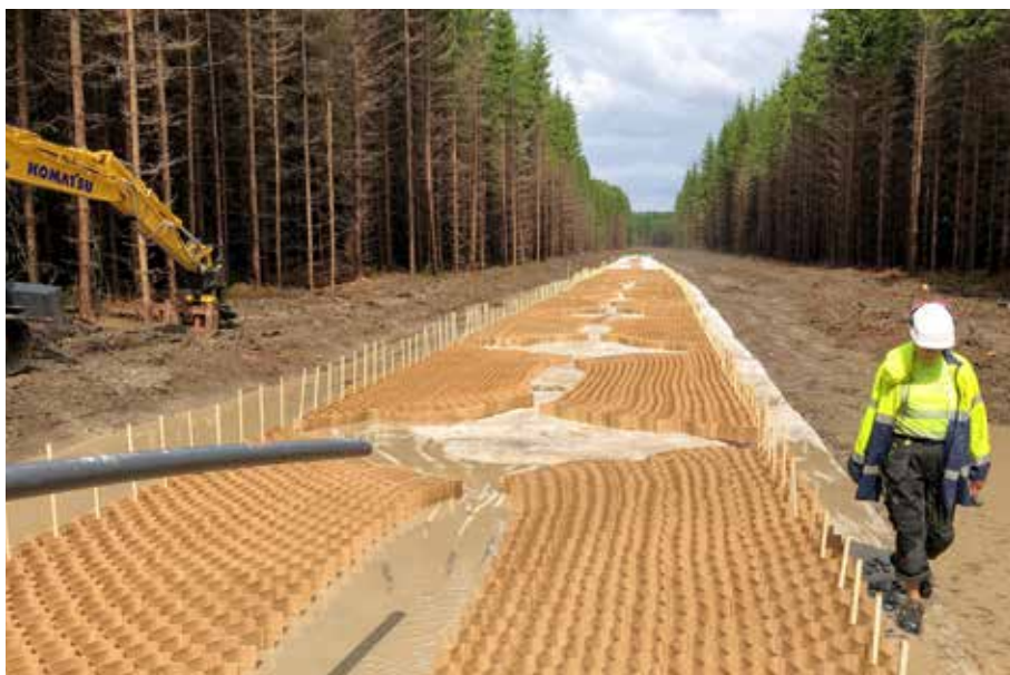
Försök med geoceller utanför Grums.
