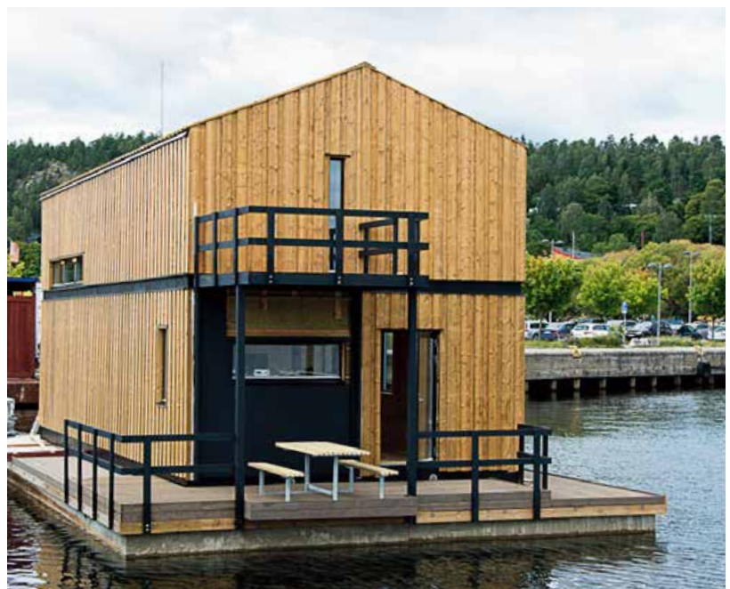
Hösten 2016 flyttade de första studenterna in i de flytande träbostäderna som byggts av trä från SCA.
