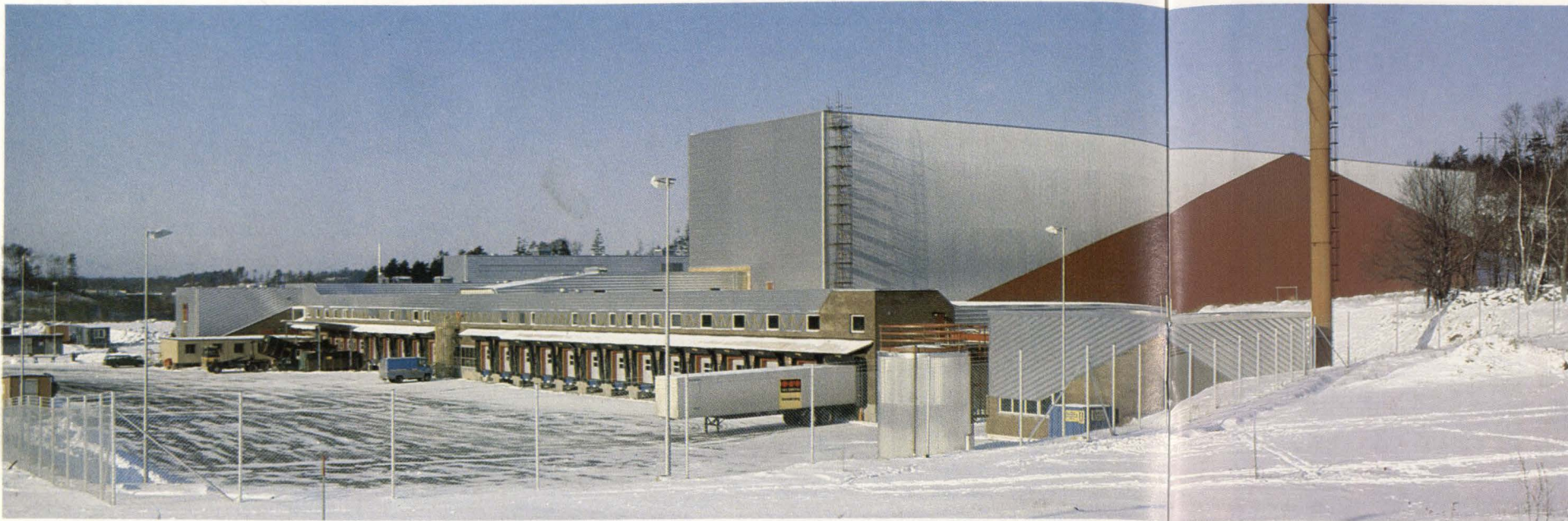
Första etappen i det sk Solstens-projektet, Mölnlyckes nya anläggning för sjukhusprodukter, kommer att successivt tas i bruk under våren 1983. Anläggningen omfattar ett helautomatiserat höglager och en produktionsenhet för hygienprodukter.
