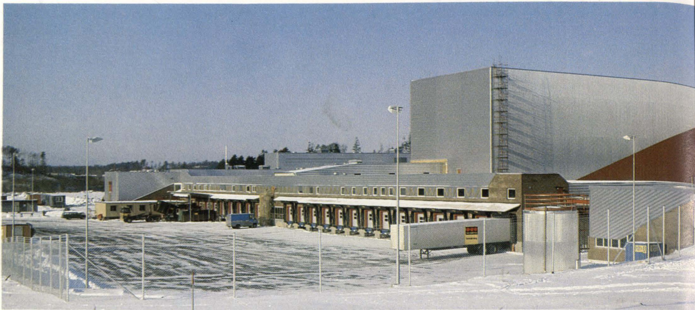
Första etappen i det s k Solstens-projektet, Mölnlyckes nya anläggning för sjukhusprodukter, kommer att successivt tas i bruk under våren 1983. Anläggningen omfattar ett helautomatiserat höglager och en produktionsenhet för hygienprodukter.
