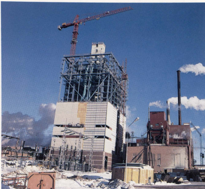
Moderniseringen av Östrands sulfatfabrik fortlöper planenligt. I förgrunden den ca 80 meter höga byggnaden för den nya sodapannan.
