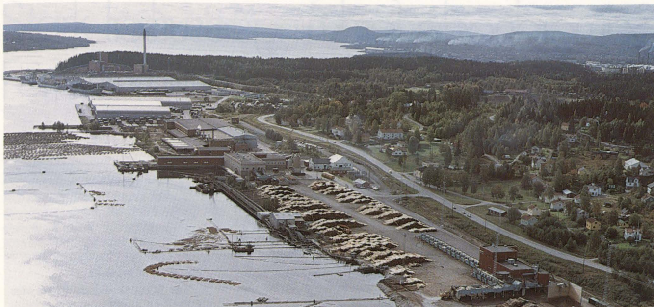
Översiktsbild av Tunadals sågverk. Längst t h den nya timmerhantering som togs i bruk 1980. Därefter ses såghuset, vilket stod klart 1976. Därefter följer ströläggning, virkestork och justeringsavdelning. Längst t v ses Sundsvalls-terminalen med ett av SCAs specialfartyg vid kaj. Byggnaderna bortom terminalen är Sundsvalls kommuns fjärrvärmeverk, vilket 1981 kompletteras med ett oljeeldat kraftvärmeverk.
