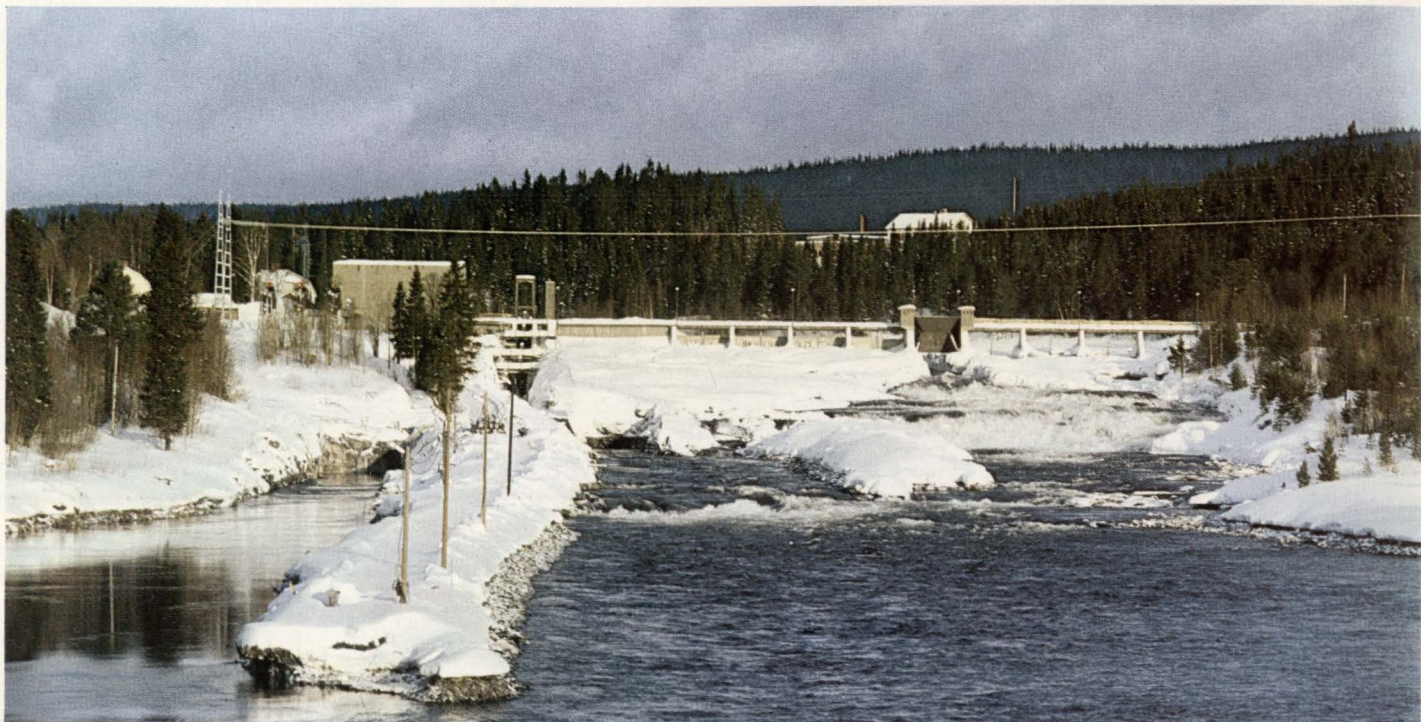
Gäddede kraftverk i Faxälven, som togs i drift i februari 1974.
