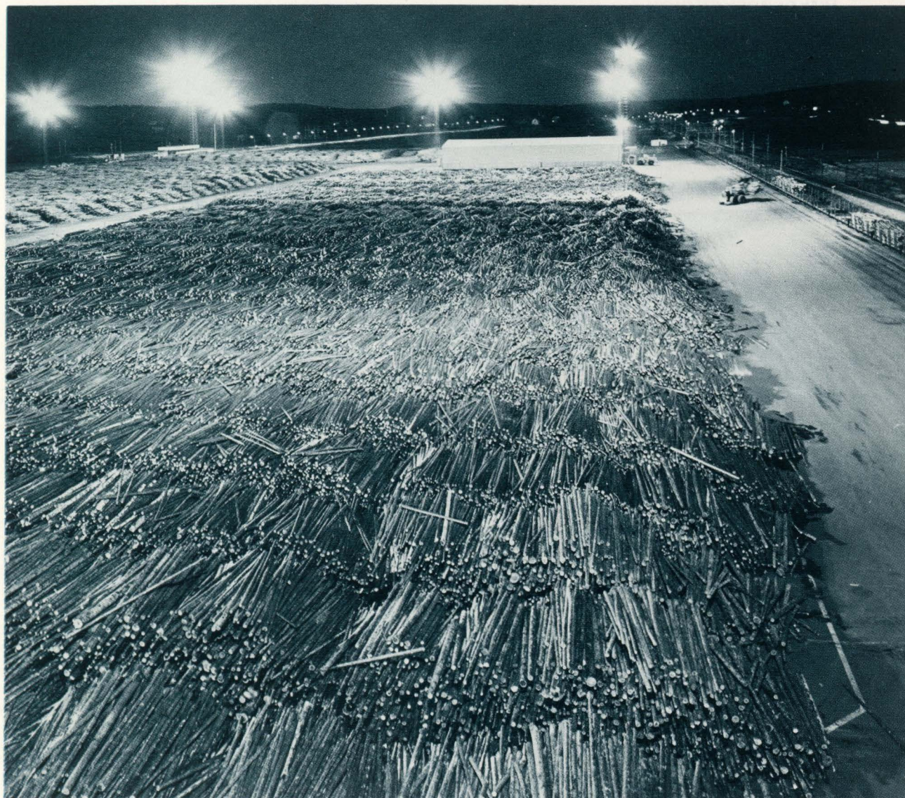
Virkesterminalen i Töva, där det järnvägs-transporterade virket inom Ljungans och Indalsälvens ådalar samlas ihop och sorteras. Terminalen har under 1972 byggts ut med ett andra sorteringsverk.
