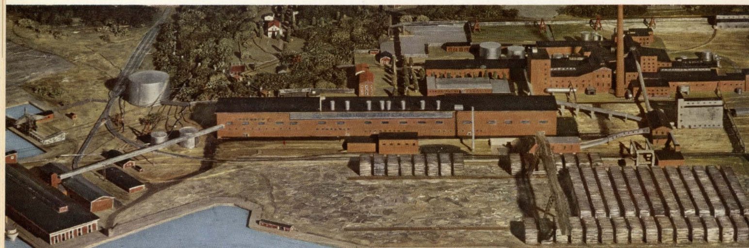
Modellfoto av Munksunds pappersbruk. Maskinbyggnaden blir 265 m lång, 20 m hög och 30 m bred. Ångpannehuset blir 30 m högt.
