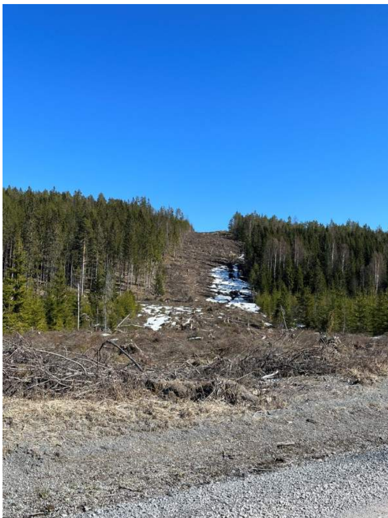
Figur 10. Vy upp mot Bodberget. Fotot visar nyligen avverkad skogsgata för E.ON:s planerade ledningar.
